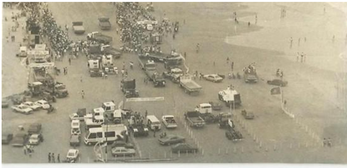
Foto 4 - Arrancada de Caminhões à beira mar
